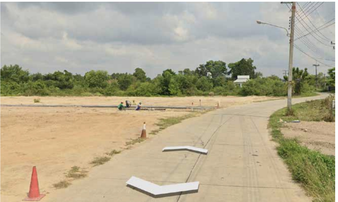
The neighbouring property will be prepared for construction ที่ดินติดกันกำลังจะดำเนินโครงการ
